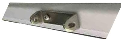
Luego colocamos los soportes con forma de L en los extremos del marco exterior inferior de la ventana, asegurandose de que se respeten las medidas mostradas en el gráfico a continuación.
